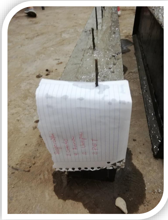
Secado de placas de concreto
