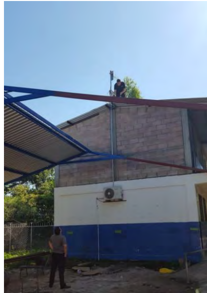
Fig. 12 Instalación de Antena en Centro Escolar Cantón Hato Nuevo
