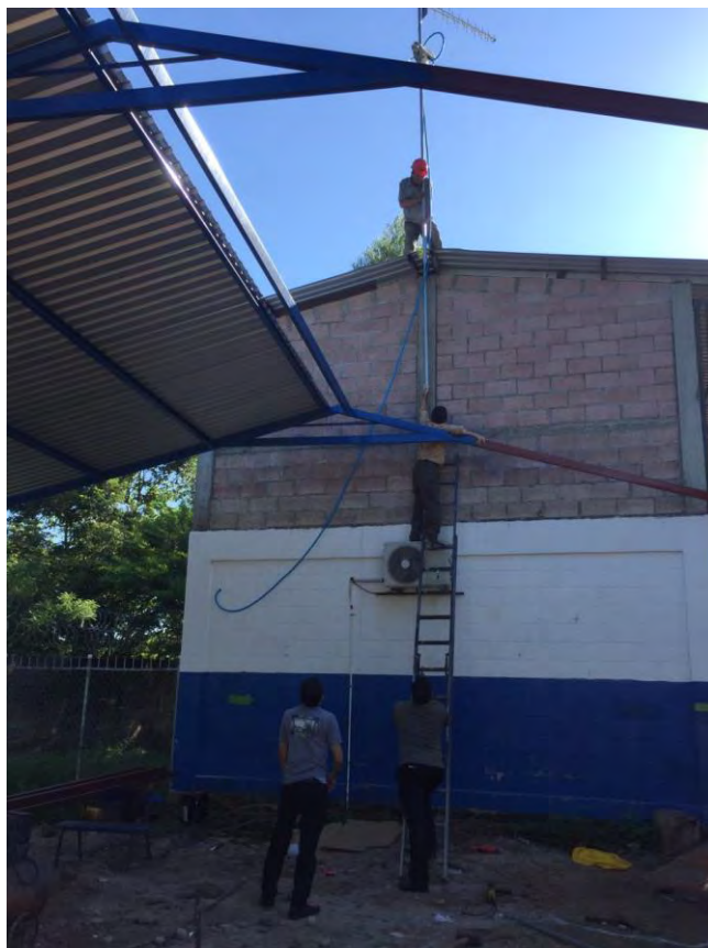
Fig. 3 Instalación de Receptor en Centro Escolar Cantón Hato Nuevo.
