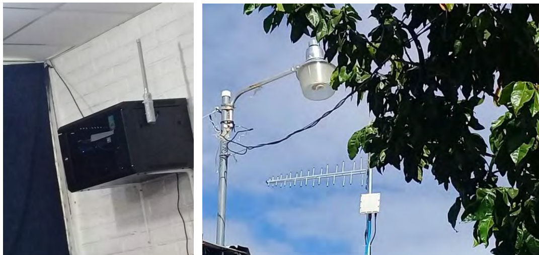
Fig. 14 Instalación de Equipos de Red y Equipo de TVWS en Centro Escolar Cantón Mejcapa.
