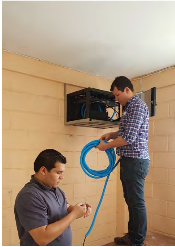
Fig. 5 Instalación Equipo de Red en Centro Escolar Cantón Hato Nuevo.
