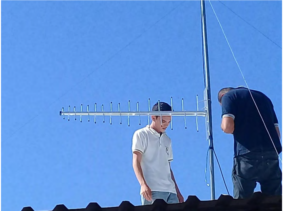
Fig. 15 Instalación de Antena de TVWS Cantón El Volcán.
