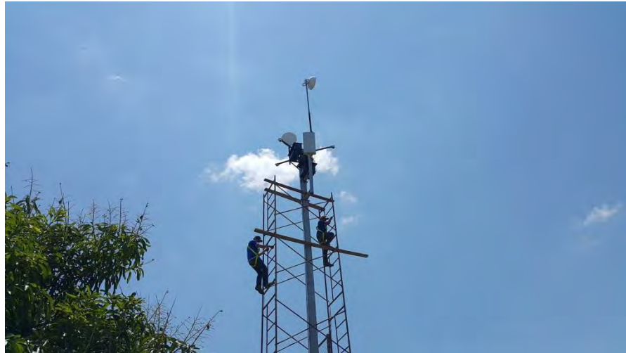
Fig. 10 Instalación de BTS en Universidad Gerardo Barrios San Miguel
