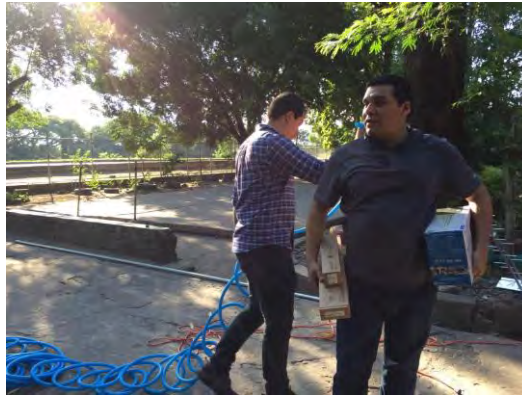
Fig. 11 Instalación de Cable de Conexión en Centro Escolar Cantón El Papalón.
