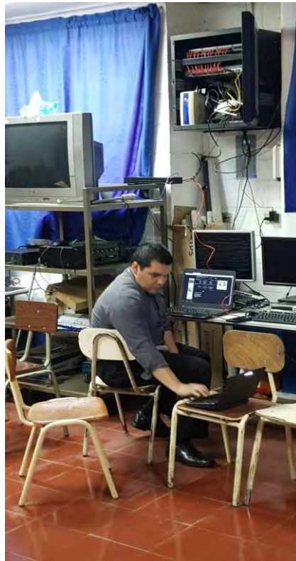
Fig. 13 Instalación de Red en Centro Escolar Confederación Suiza
