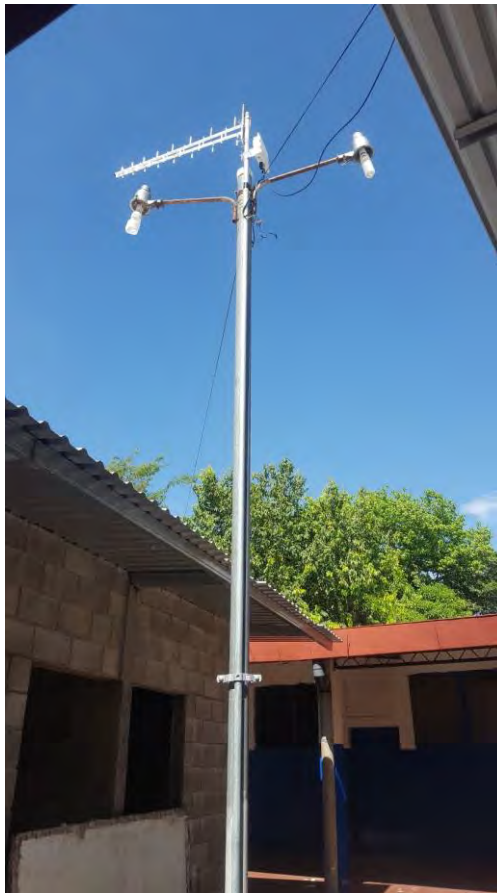
Fig. 16 Antena de TVWS Instalada en Instituto Nacional Ereaguayquin.
