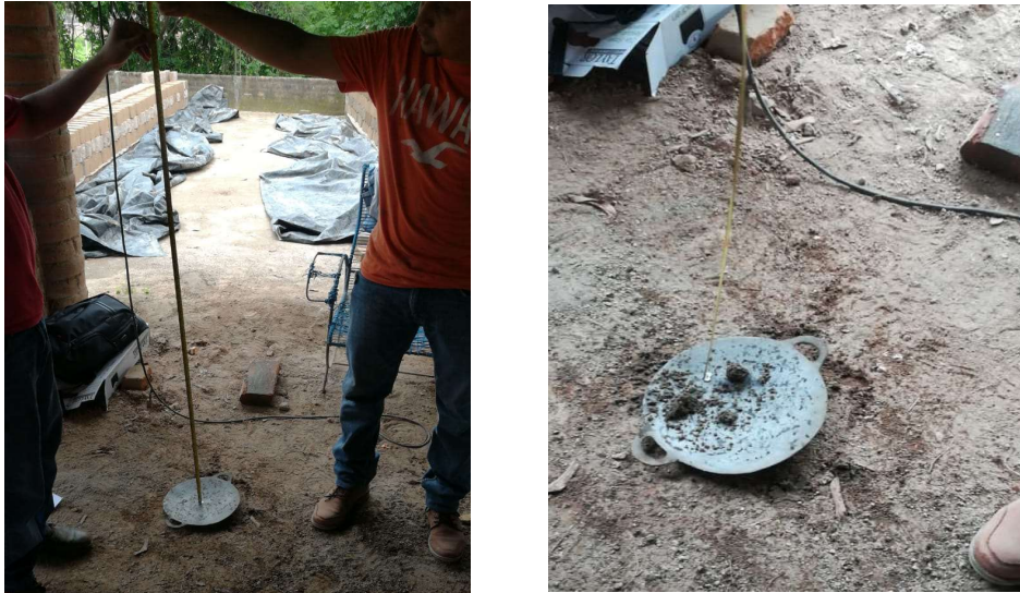
Ilustración 14. Verificación de humedad.
