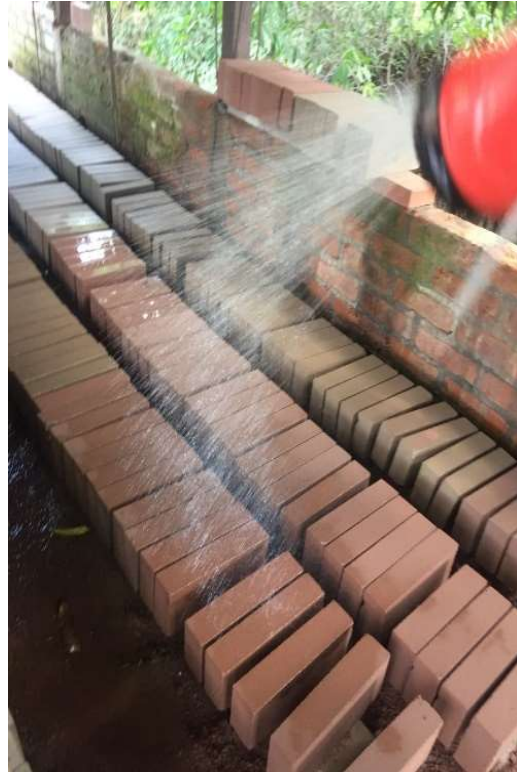
Ilustración 9. Acopio y Curado de Ladrillo
