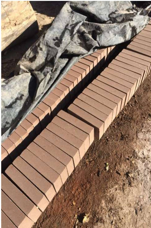
Ilustración 9. Acopio y Curado de Ladrillo
