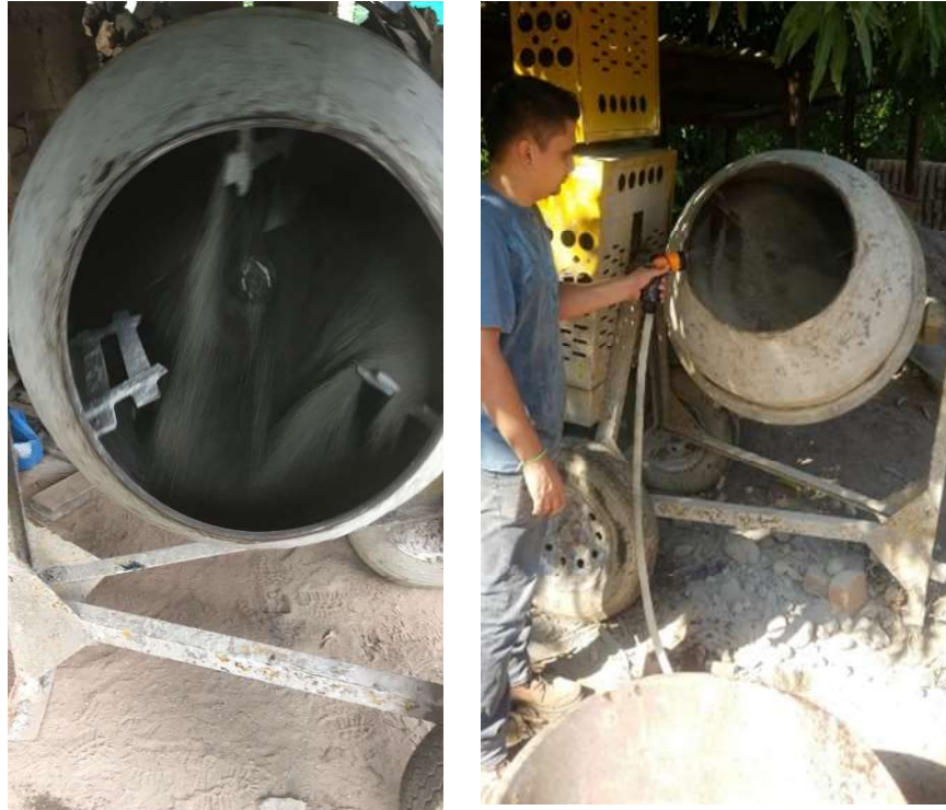
Ilustración 13. Mezclado de los agregados
