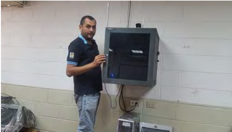
Ilustración 13: Instalación de equipo IoT en Centro Escolar Miguel Guevara.
